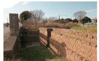
現在の瓦葺掛樋跡
