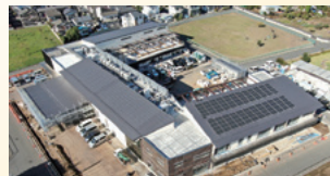
建設中の複合施設
