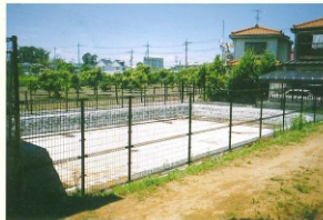
地区の西側に整備された調整池
