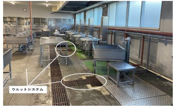
↑ドライシステムが未導入となっている給食施設
