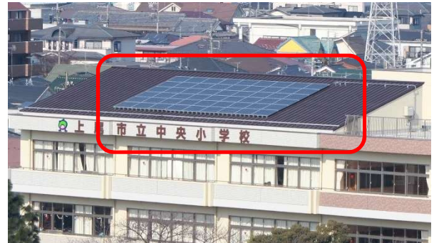
中央小学校の太陽光パネル
