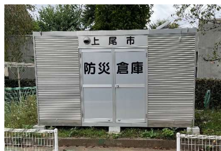
学校敷地内の防災倉庫
