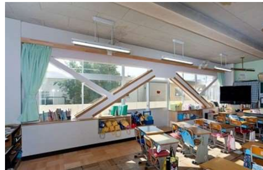
耐震補強後の教室の様子
