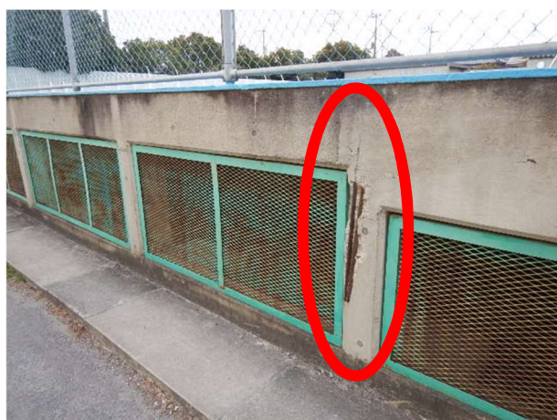
大石中学校プール施設
