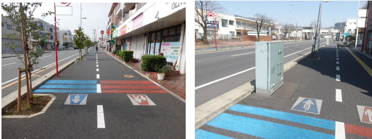
図-2.2 上尾市道の無電柱化整備区間（市民体育館通り）
