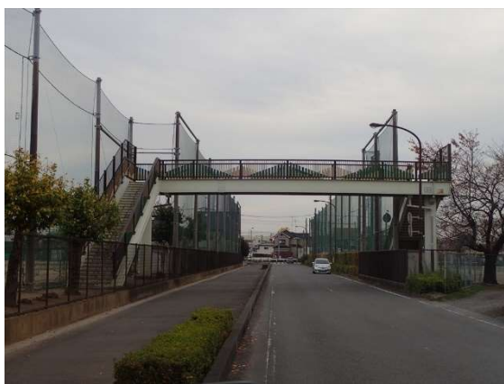
○東中学校歩道橋
