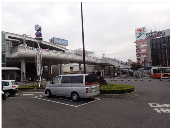
○上尾駅西口ペデストリアンデッキ
