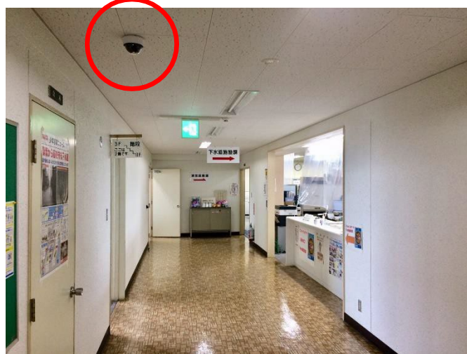
防犯カメラの設置（下水道施設課）
