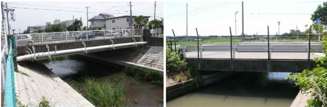
写真 2 河川,用水路を跨ぐ橋(左:鴨川を跨ぐ新弁財橋、右:見沼用水を跨ぐ坂下橋)
