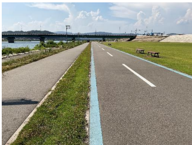
河川管理用通路、サイクリングロード、芝生広場
