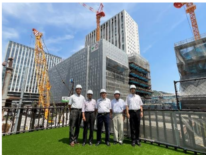
広島駅南口広場再整備 見学ルーム
