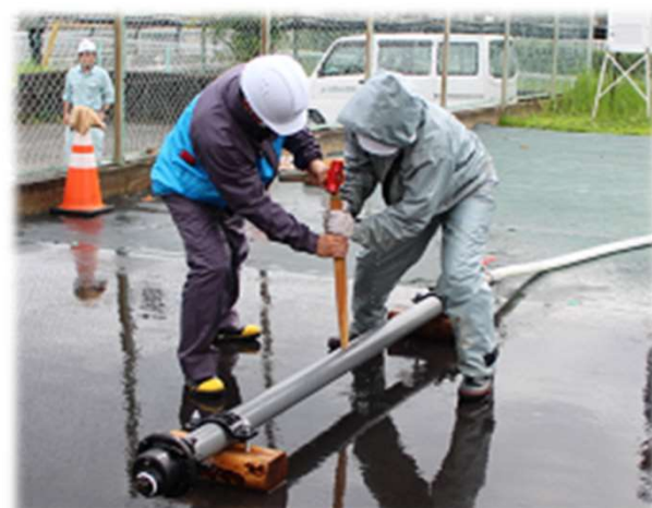
《セットハンマーにて木栓の打ち込み》
