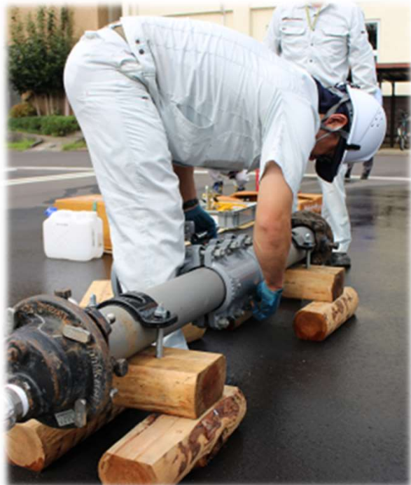
《不断水割丁字管設置》
