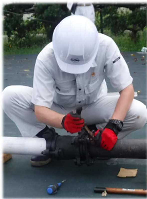
《ボルト締め込み(新設側)》
