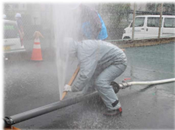
《木栓の先端を漏水箇所へセット》
