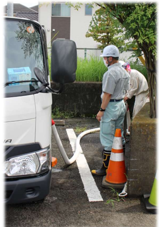
《消火栓から給水車タンクへの飲料水充填》
