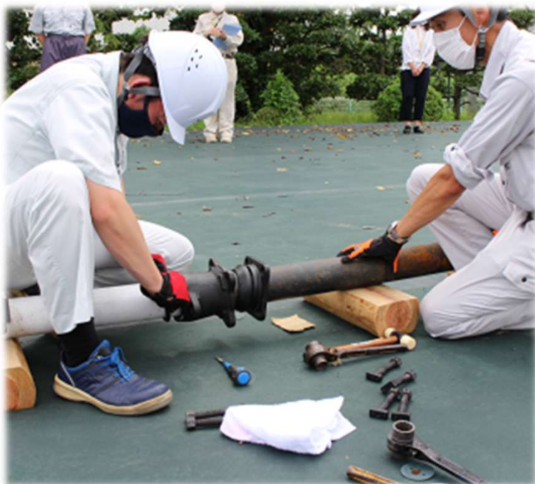
《接合部材設置(新設側)》
