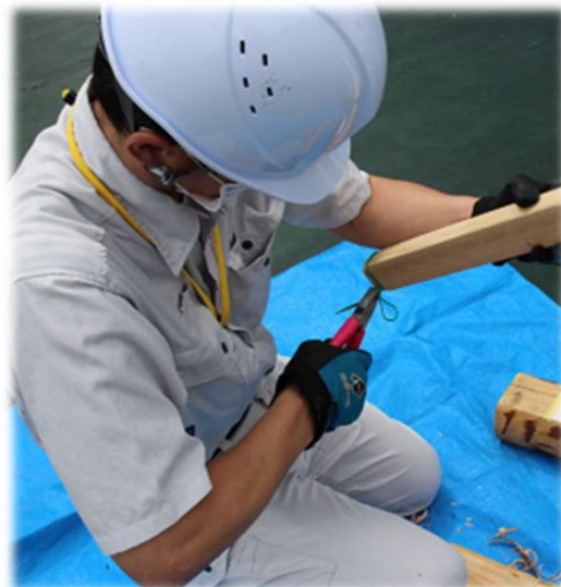
《割れ止め巻き付け》
