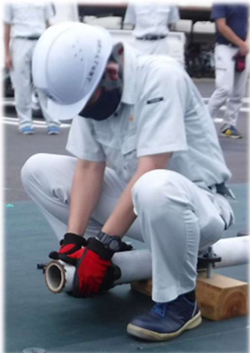
《接合部材設置(破損側)》
