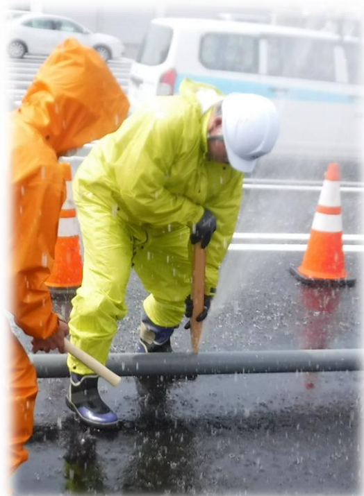
② 全体重をかけて木栓の差し込み
