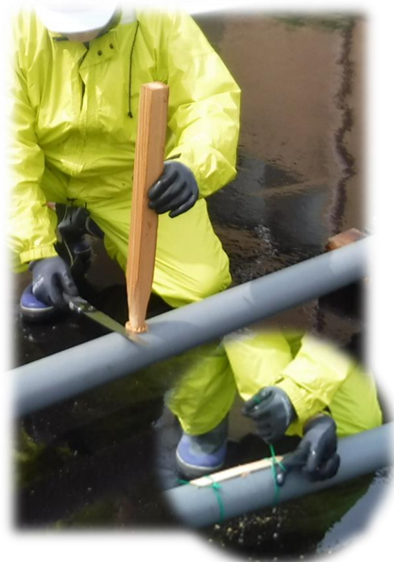
④ 応急止水完了 (最終的に木栓を切断し止水箇所を養生)
