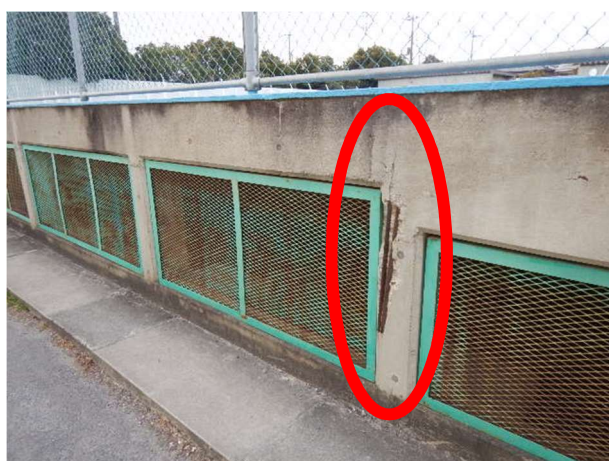
大石中学校プール施設
