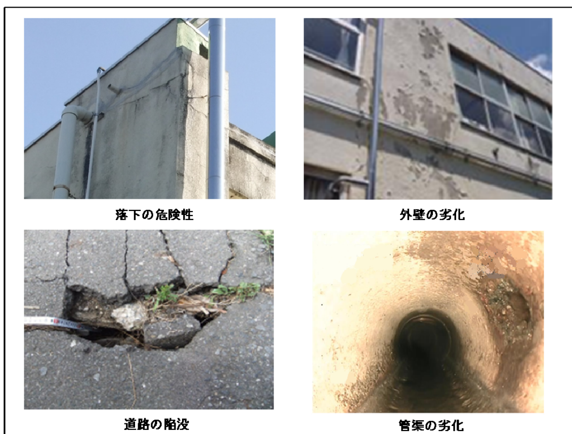
図表 3-9 緊急性のある現場の例
