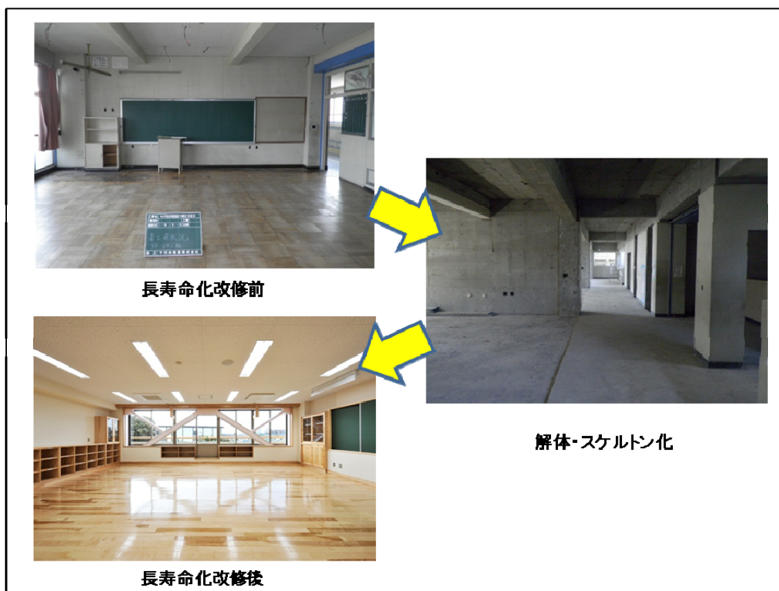
図表 3-12 長寿命化工事の例
