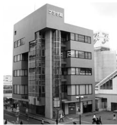
上尾駅東口のプラザ館
