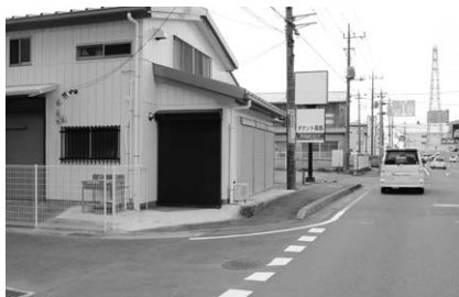
降雨時に冠水する学童の前面道路
