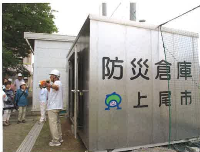
3、芝川小学校防災倉庫の確認
