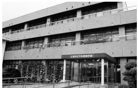
商工会議所の一時移転先となる上下水道部庁舎
