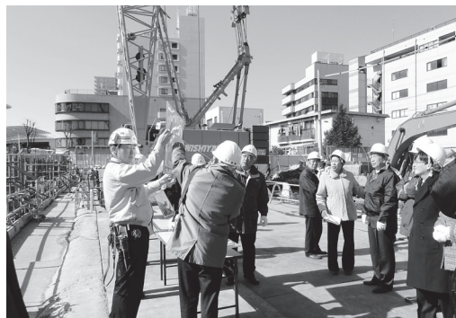
建設水道消防常任委員会の上尾 中山道東側地区市街地再開発事 業の現地調査の様子
