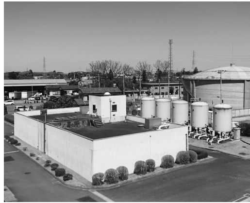
着水井・混和池(手前の建物)
