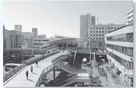
平成25年3月 JR上尾駅東口ペDESTリアンデッキが完成
