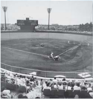
平成10年9月 上尾市民球場が開場
