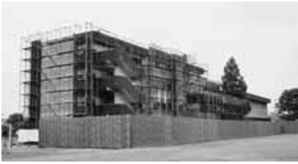
大規模改造工事が行われている芝川小学校C・D棟
