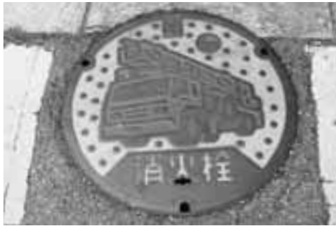
市道上の消火栓
