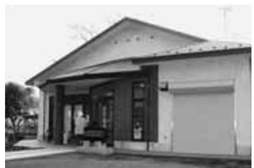
平成19年3月に完成した谷津集会所
