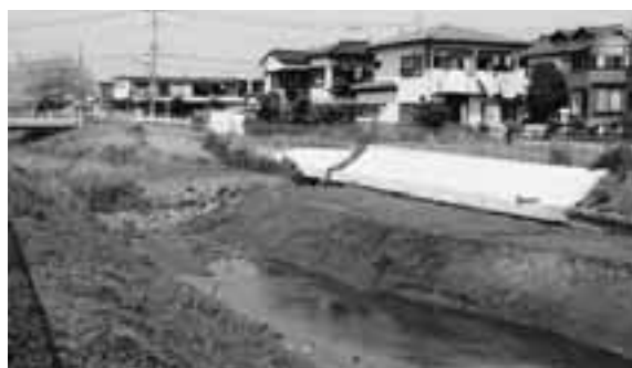
各所で改修の進む鴨川
