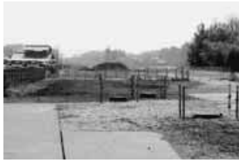
工事の進む上尾道路予定地
