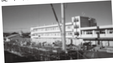
改築中の校舎
