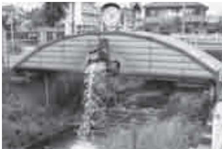
かぶと橋(井戸木四丁目)
