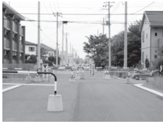
区画整理事業地内の新しい道路(今泉地内)
