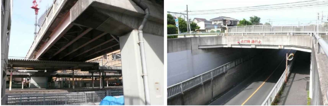
写真 1 跨線橋,跨道橋(左:JR を跨ぐ宏栄橋、右:市道を跨ぐ小敷谷吉田通線アンダー西)
