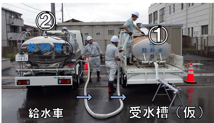
6.給水車から可搬式応急給水タンクへの圧送
