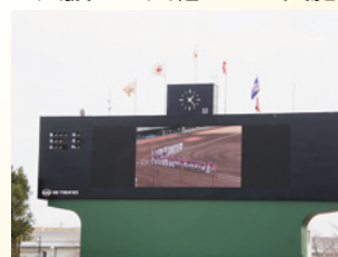
改修後のスコアボード
