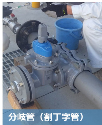
水道管分岐作業（φ50）
