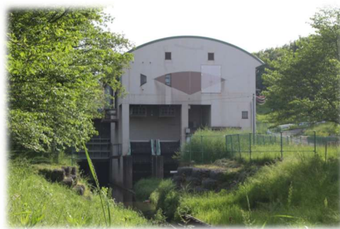
丸山ポンプ場
