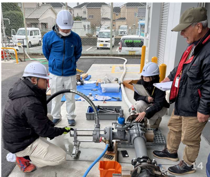
穿孔機を使用し 铸铁管に直径75mmの 配水管分岐孔を開ける
