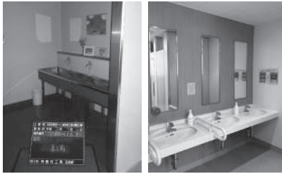
平成24年に改修された大谷中学校のトイレ (左が改修前、右が改修後)
