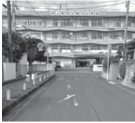
路面標示が消えかかっている鴨川小学校周辺の道路
